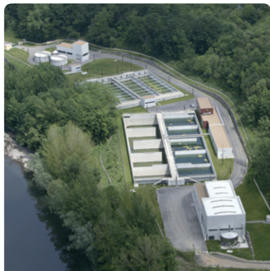
Depuradora de las Caldas en construcción junto al río Nalón | Las Caldas WWTW alongside the River Nalón
