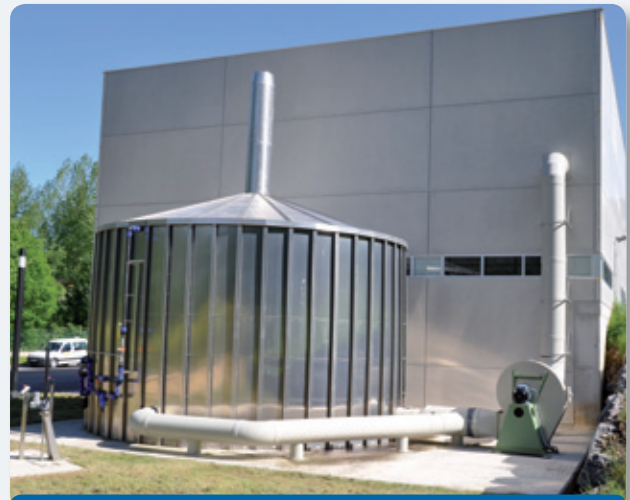
Biofiltro percolador para eliminación de olores del edificio de pretratamiento Percolating biofilter for odour removal in pretreatment building
