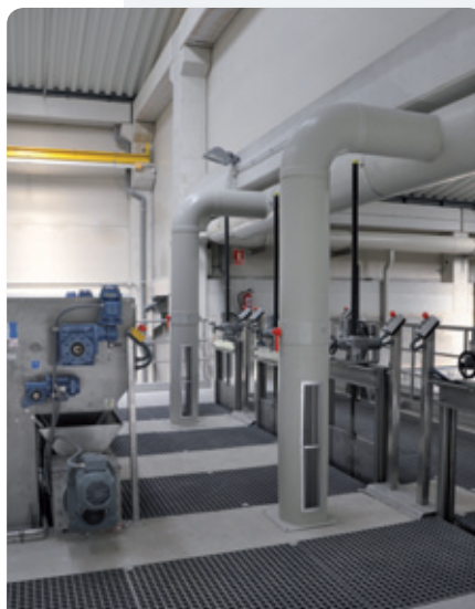
Instalación de extracción en zona de tamices Extraction facility in the screening area
