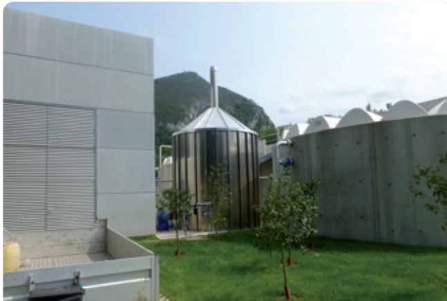
Biofiltro percolador para eliminación de olores del edificio de deshidratación de fangos Percolating biofilter for odour removal in sludge dewatering building
